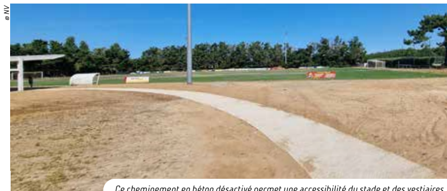
Ce cheminement en béton désactivé permet une accessibilité du stade et des vestiaires aux personnes à mobilité réduite.
